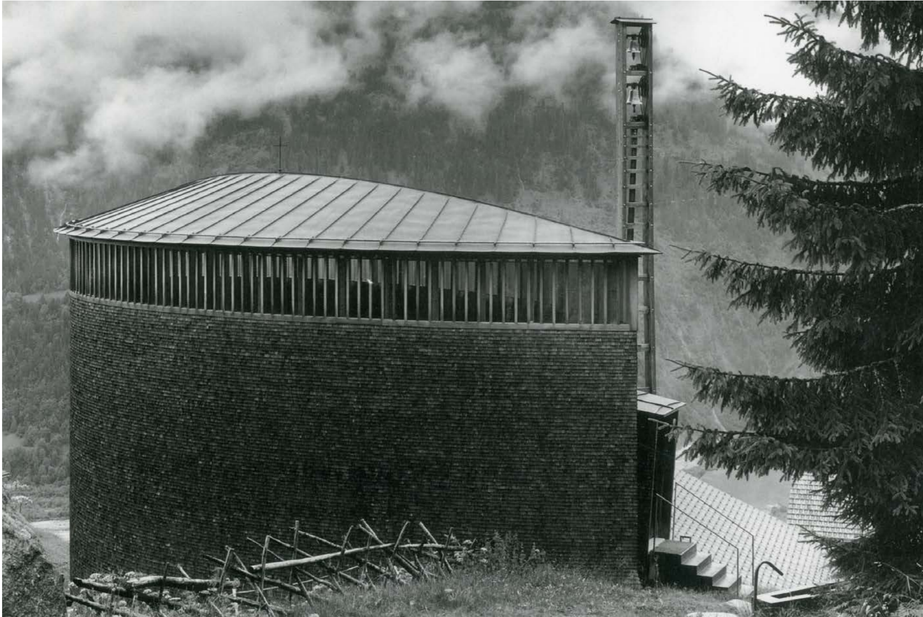
Peter Zumthor, Jürg Buchli und Jürg Conzett: Kapelle Sogn Benedetg, Sumvitg, Graubünden, 1989
